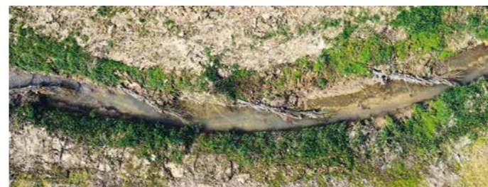
Diversification des écoulements par pose d'épis de saules vivants - Coudures (40) - Cours d'eau du Gabasset - bassin versant du Gabas © SGLB
