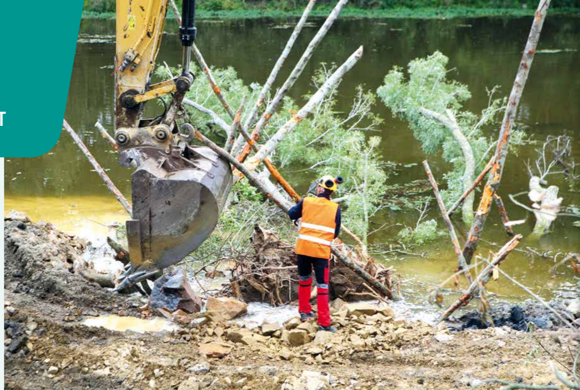
Ancrage d'un enchevêtrement d'arbres entiers dans le Thouet (2026)
